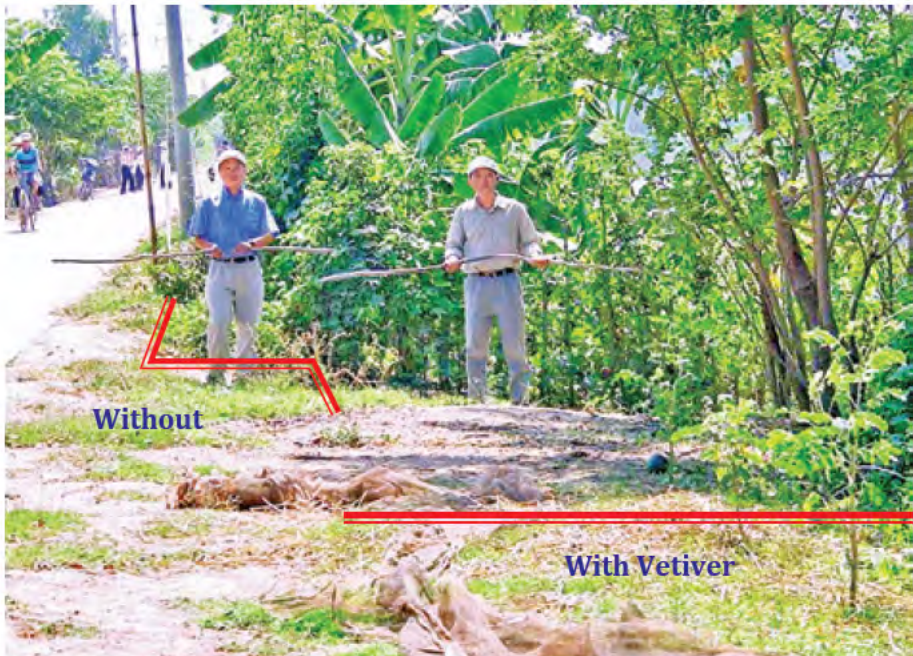
Hình 6.16: Công trình Trồng cỏ Vetiver bảo vệ đường giao thông nông thôn ở huyện Tân Châu An Giang sau 2 mùa lũ
