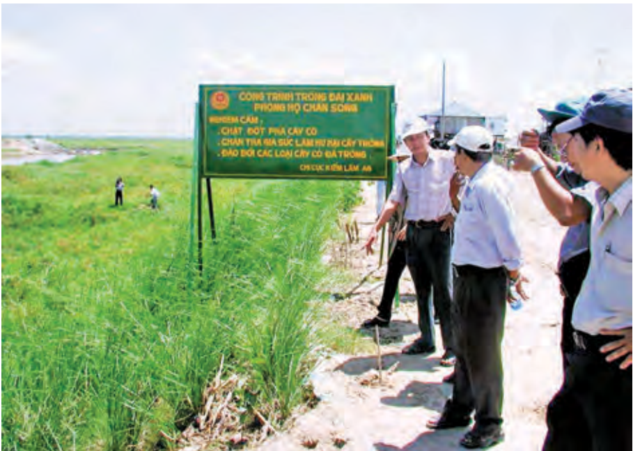
Hình 6.17: Điểm trồng cỏ Vetiver bảo vệ đường giao thông nông thôn ở huyện Tân Châu (An Giang) lúc mới bắt đầu và sau 4 tháng trồng
