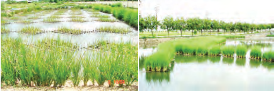
Hình 4.6: Trái: hệ thống xử lý Vetiver hồ chứa nước thải chăn nuôi heo ở Biên Hòa, Việt Nam, và phải: ở Trung Quốc ((Paul Trương et al., 2008)
