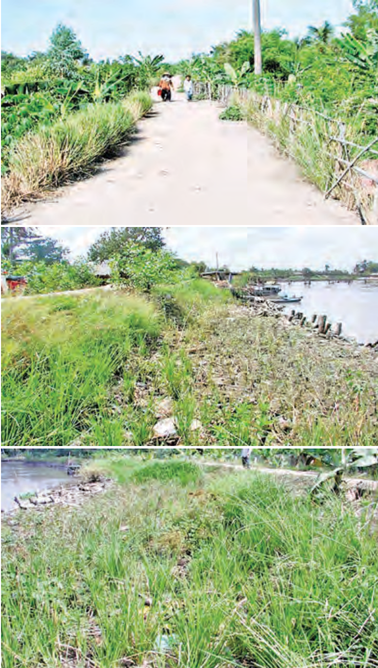
Hình 6.15: Trồng cỏ Vetiver bảo vệ đường giao thông nông thôn ở tỉnh Tiền Giang đã đạt được kết quả tốt
