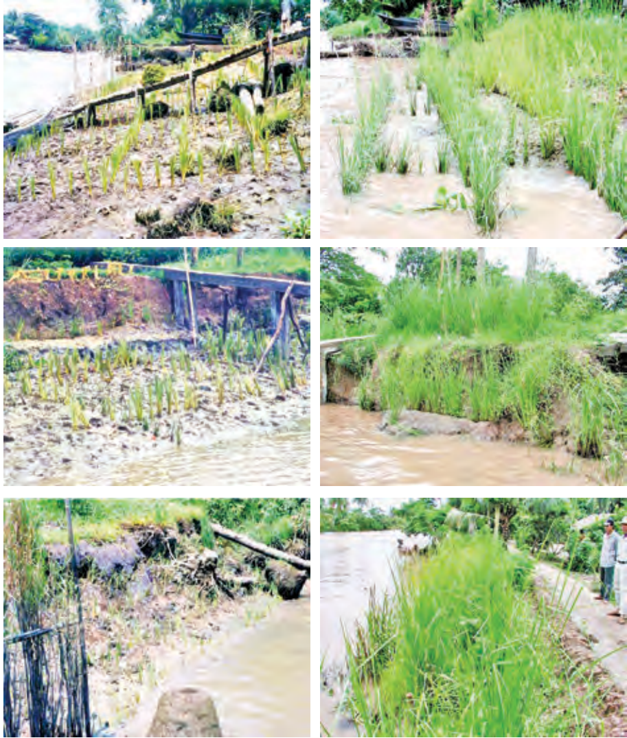
Hình 6.11: Trồng cỏ Vetiver chống sạt lở bờ sông ở các điểm thí nghiệm Cần Thơ (A) bắt đầu trồng và (B) sau 4 tháng
