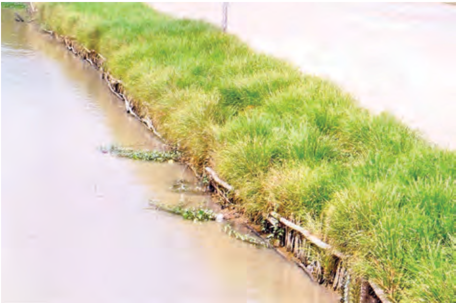
Hình 6.12: Trồng cỏ Vetiver chống sạt lở bờ sông ở các điểm thí nghiệm nông trường Cờ Đỏ thành phố Cần Thơ
