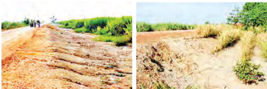
Hình 5.1: Nền đường trên đất chua phèn nặng ở Tiền Giang trước và sau khi trồng cỏ Vetiver
