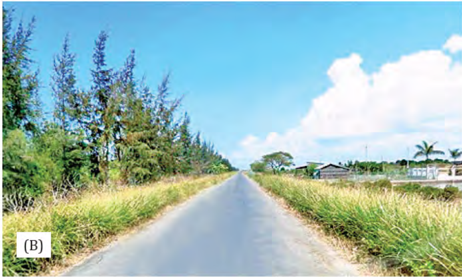
Hình 6.27: (A) 8 năm và (B) 12 năm sau trên cùng 1 tuyến đê cho thấy cỏ Vetiver phát triển rất tốt, bảo vệ vững chắc cho tuyến đê
