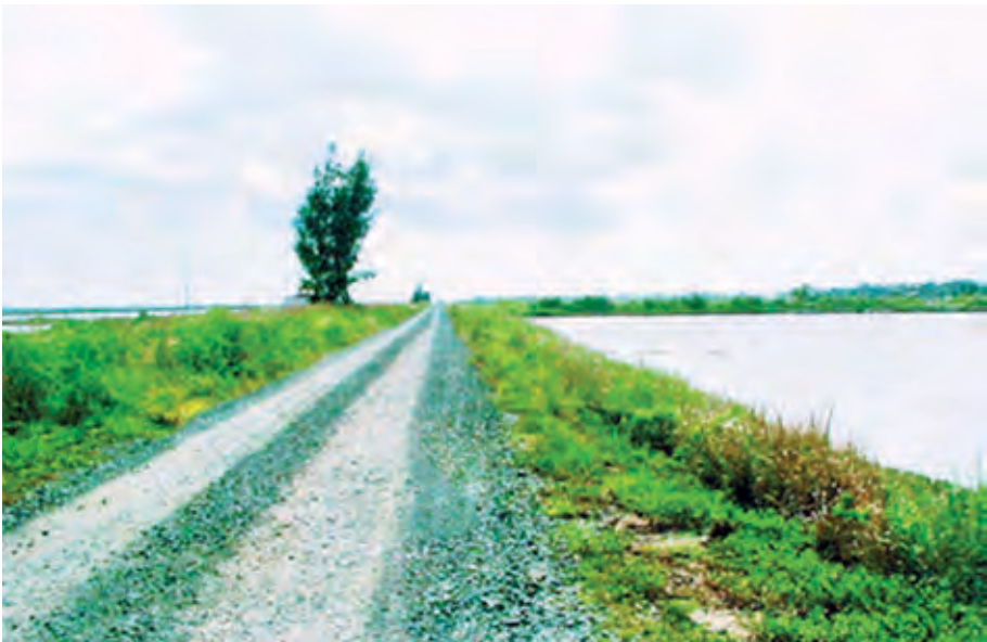
Hình 6.24: Ảnh chụp 06/2007, 4 năm sau khi xây dựng tuyến đê dài 11km. Nó được xây dựng thử nghiệm để xác định sự phù hợp của cỏ Vetiver trong việc ổn định đê bao
