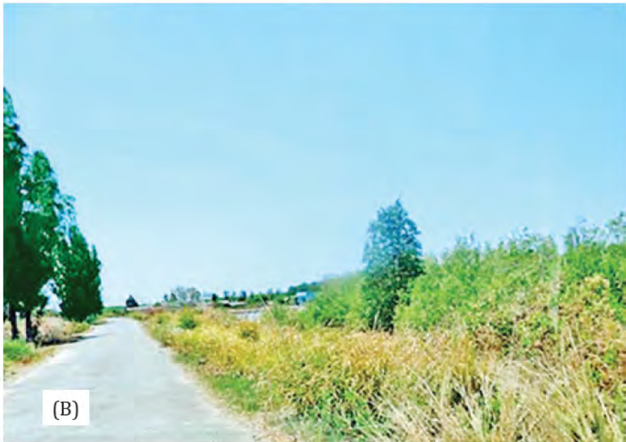
Hình 6.28: (A) mặt ngoài và (B) mặt trong của tuyến đê sau 12 năm cỏ Vetiver phát triển rất tốt, bảo vệ vững chắc cho tuyến đê
