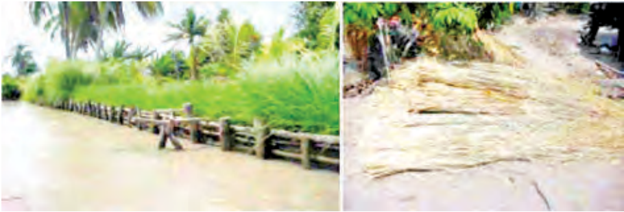
Hình 5.7: Trồng cỏ Vetiver gia cố một đoạn bờ kè gỗ dọc sông (trái) và lá cỏ được cắt ra, phơi khô làm lát buộc lúa (phải)
