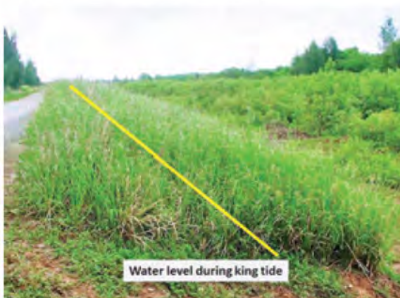
Hình 6.26: Mặt ngoài đê bao chịu ảnh hưởng thường xuyên của thủy triều dâng cao và sự ngập mặn nhưng cỏ Vetiver vẫn sống sót và vượt lên trong điều kiện này
