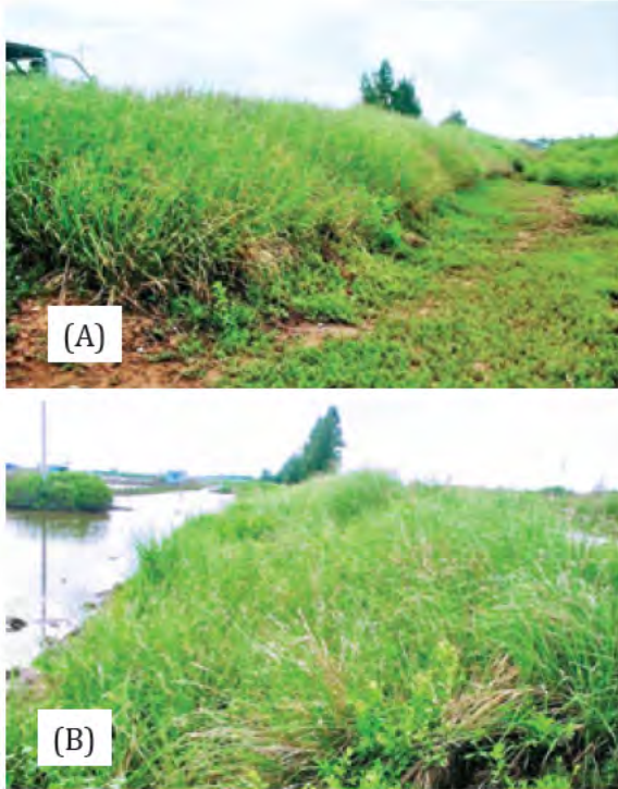
Hình 6.25: (A) Cỏ mọc tốt ở mặt ngoài đê bao, đây là mặt chịu ảnh hưởng trực tiếp của triều cường thường xuyên. (B) Cỏ mọc tốt mặt trong đê bao, đây là mặt không bị ảnh hưởng bởi triều cường
