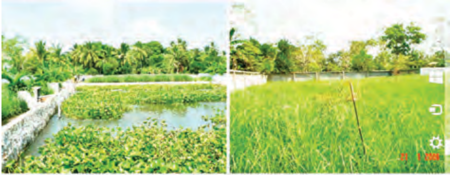
Hình 4.9: Ao xử lý nước thải bằng lục bình và cỏ Vetiver ở Công ty Thủy sản CAFATEX
