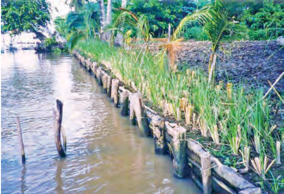
Hình 6.9: Bờ kè bằng gỗ kết hợp trồng cỏ Vetiver sau khi trồng cỏ 2 tháng (A) và 6 tháng (B)
