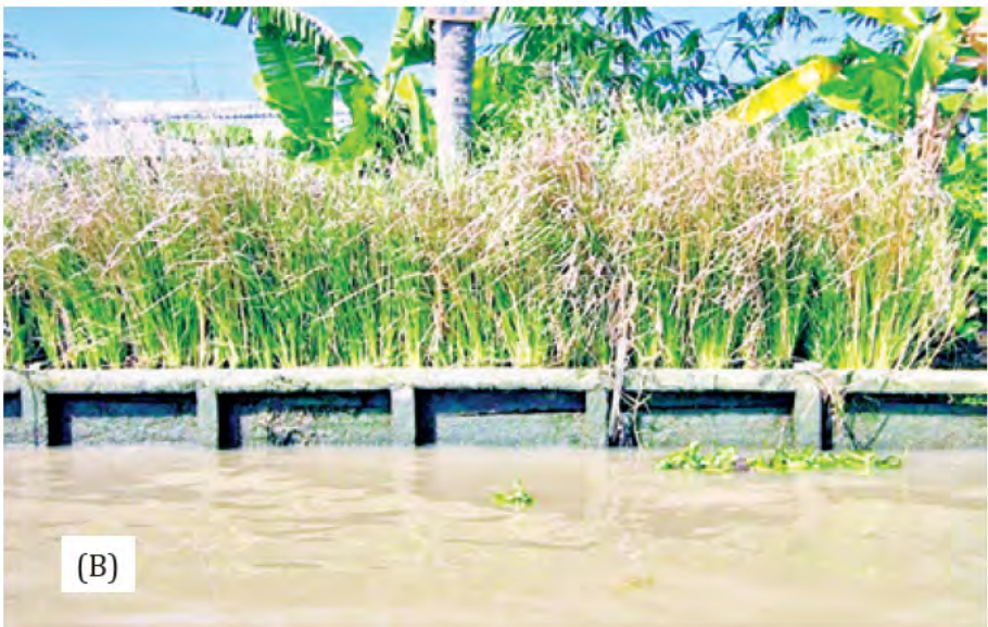
Hình 6.7: Trồng cỏ Vetiver kết hợp bờ kè bằng gỗ (A) và bờ kè bằng xi măng (B) ở hộ gia đình
