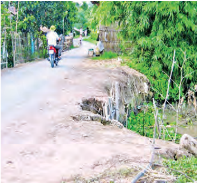
Hình 6.2: Hiện trạng bờ sông bị sạt lở đến đường giao thông nông thôn (Nguyễn Văn Đồng., 2007)
