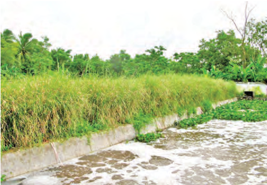
Hình 6.33: Trồng cỏ Vetiver xử lý nước thải ở công ty chế biến thủy sản CAFATEX - Hậu Giang
