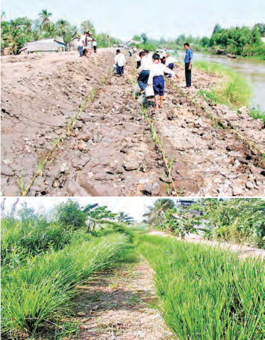
Hình 6.13: Các công trình trồng cỏ Vetiver chống sạt lở bờ sông ở các điểm thí nghiệm Cai Lậy - Tiền Giang khi mới bắt đầu và hơn 7 tháng sau
